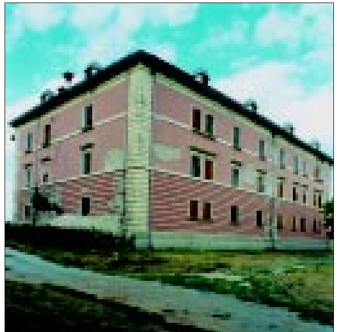
Sl. 8. Ilok, palača Odescalchi, nekadašnji palas knezova Iločkih, pogled s jugozapada (snimka Hrvatski restauratorski zavod, Zagreb)
