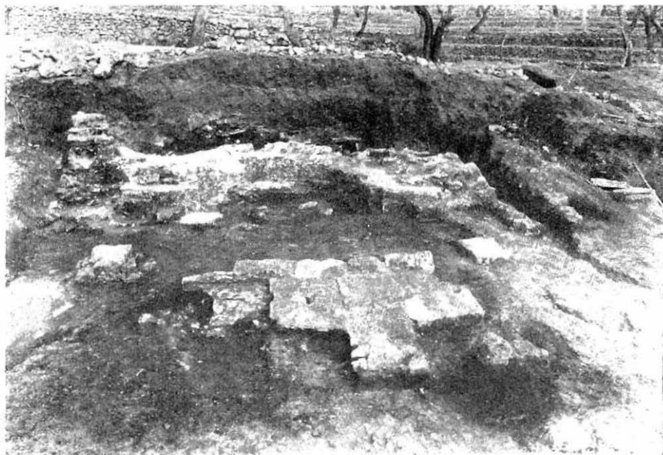
Sl. 20. Ostaci »četvrte crkve«. Snimano u toku rada. Dobro se vide: apside, pločnik, piloni i grobovi, koji podilaze pod podvornicu Đure Bukorovića
