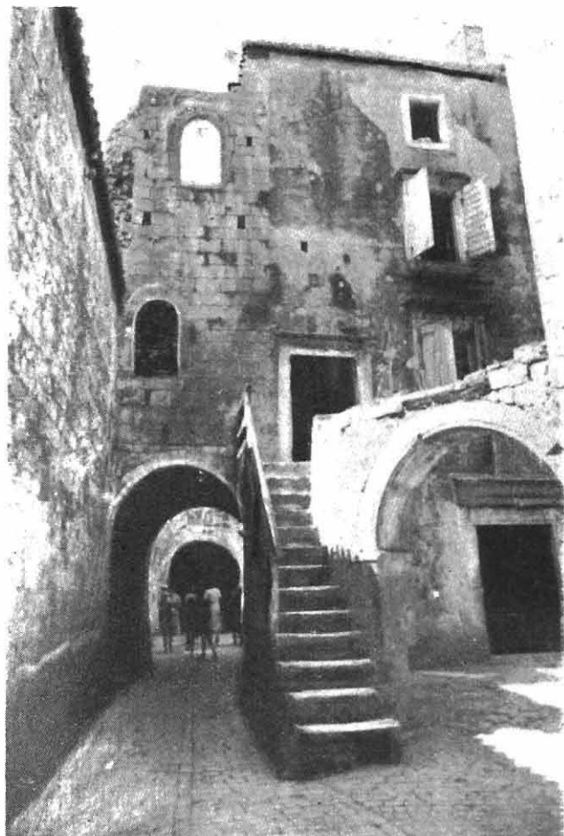
Sl. 32. Porušena kuća nad uličnim svodom i stubištem u Trogiru
