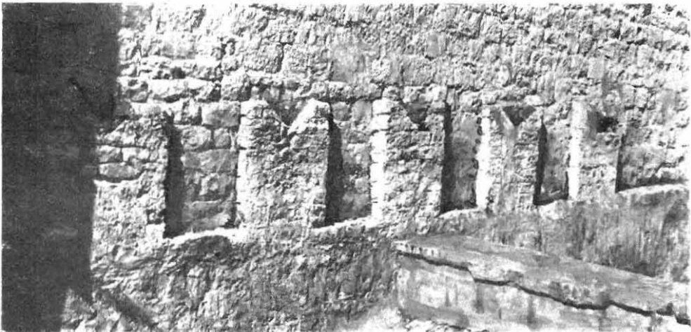
Sl. 56. Krunište obrambenog zida kuće u Severcoj ulici u Splitu
