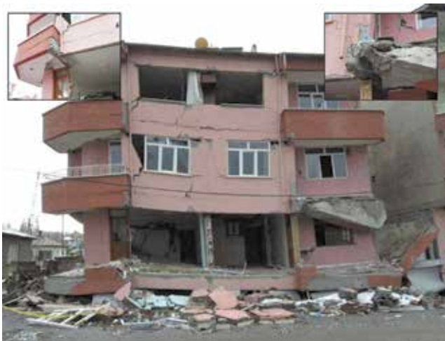
Slika 16. Šteta u Ercișu nastala zbog odabira neodgovarajućih konstrukcijskih sustava
