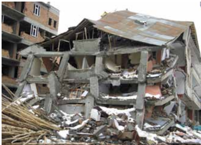
Slika 10. Rušenje zgrade u Ercišu zbog translacijskog pomaka čvorova nakon plastičnog zakretanja na kraju svakog stupa na katu
