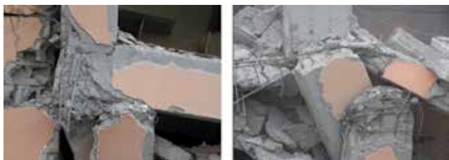
Slika 11. Karakterističan slom spojeva na višekatnici u Ercišu
