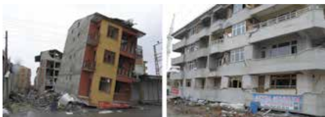
Slika 12. Rušenje dviju zgrada u Ercišu zbog mekog kata u prizemlju
