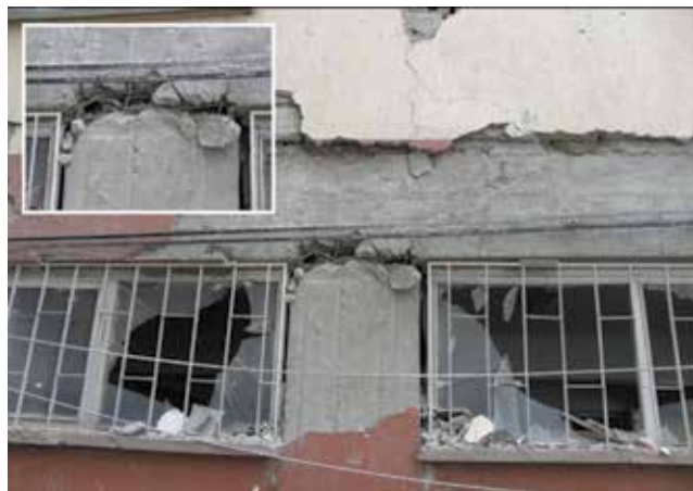
Slika 13. Posmični slom na vrhu stupa zgrade u Vanu uzrokovan kratkim područjem posmika
