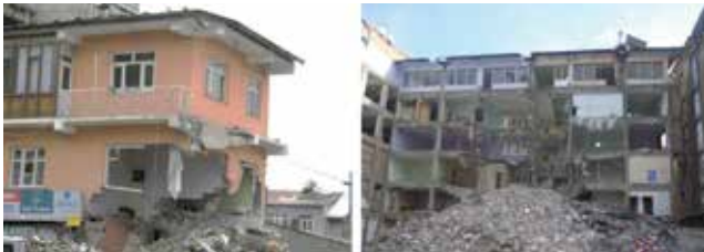
Slika 15. Šteta koju je u Ercișu i Vanu prouzročilo rušenje zgrade na susjedne zgrade
