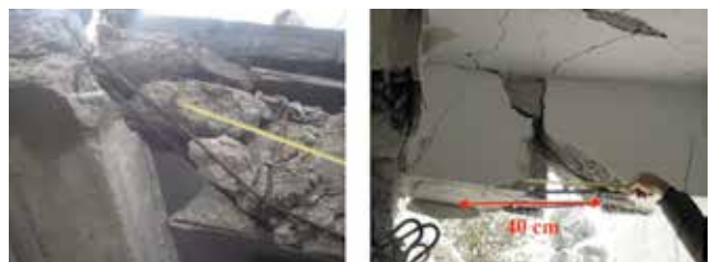
Slika 28. Neodgovarajući razmaci poprečne armature
