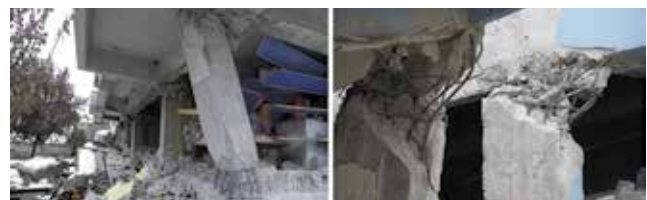
Slika 9. Primjeri plastičnog zakretanja na krajevima stupova u Ercișu
