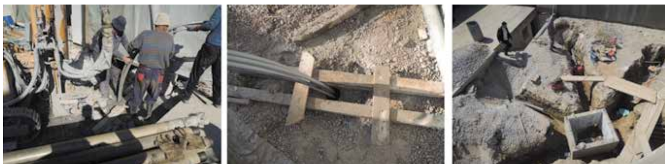
Slika 15. Izrada bušotina i montaža geotermalnih sondi
