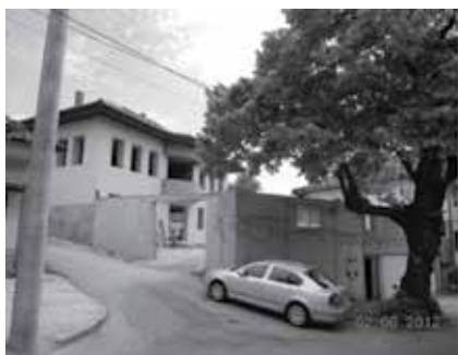
Slika 10. Prikaz prve faze radova na stambenoj zgradi Vrbanjuša (2012.)
