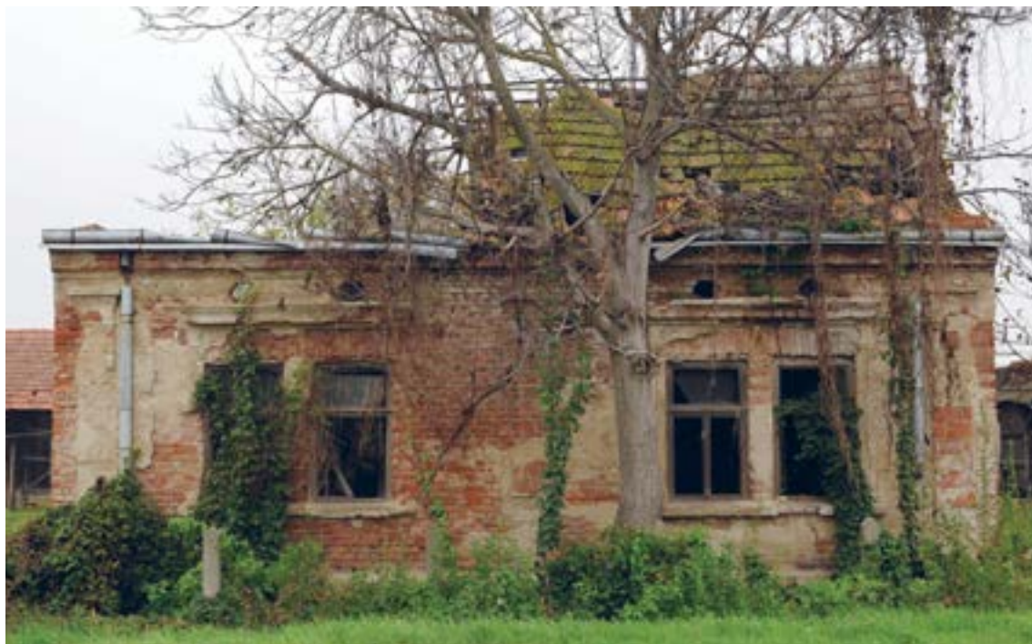
Slika 21. U podravskim selima sve je više napuštenih kuća koja naočigled propadaju - primjer kuće iz Novigrada Podravskog, Virovska 63 (R. Ibrišević, 2011.)
