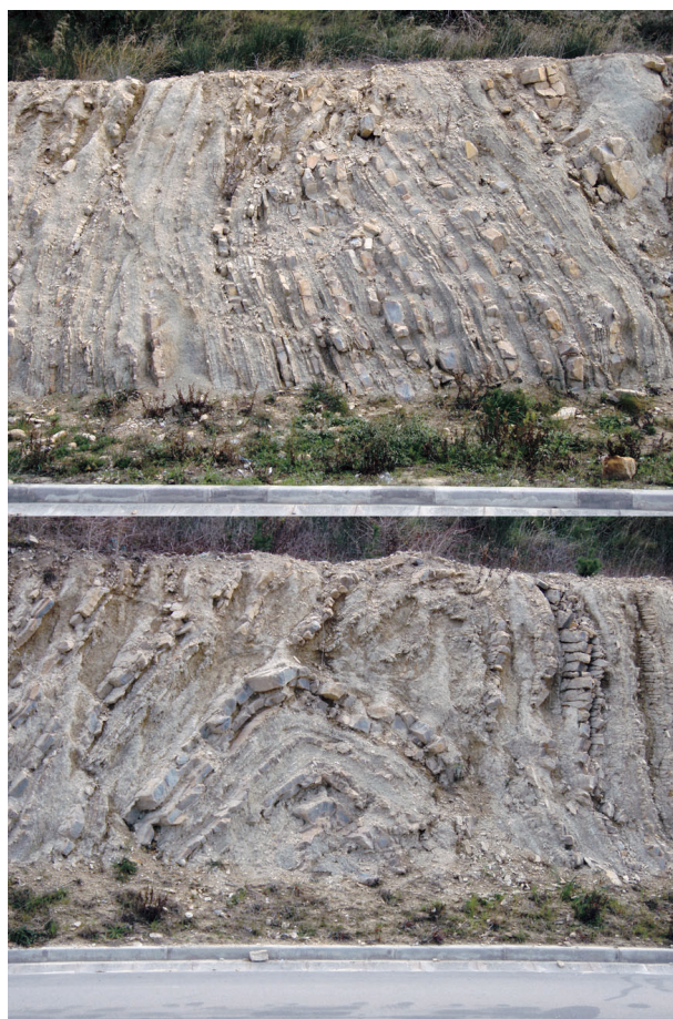
Slika 5. Razlomljenost boranih slojeva flišnog slijeda kao posljedica tektonskih naprezanja kojima je stijenska masa bila izložena tijekom svoje geološke prošlosti. Rezultat je savijanje i povećanje kuta nagiba slojeva što dovodi do nastanka pukotina okomitih na slojne plohe. (Trgovački centar Kaštela, Kaštel Sućurac, foto Aleksandar Toševski).
