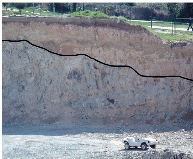
Slika 11. Zona trošenja lapora snimljena na istočnom profilu sjever – jug građevne jame Sveučilišne knjižnice u Splitu (foto Aleksandar Toševski)
