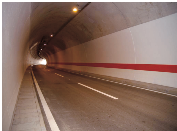
Figure 1. View on tunnel tube Slika 1. Pogled na tunelsku cijev
