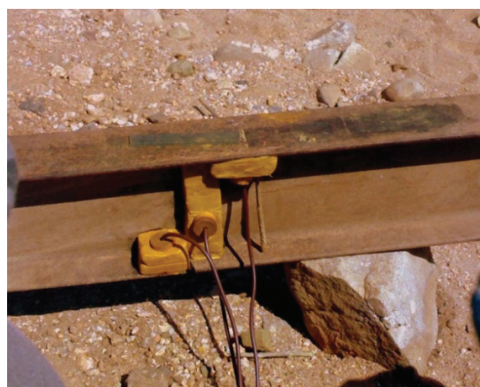
Slika 5. Primjena plastičnog eksploziva za rezanje metala
