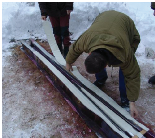
Slika 11. Postavljanje eksploziva na metal (Havliček & Nesvadba 2011)
