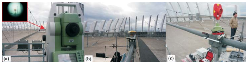
Slika 10. Robotizirana mjerna stanica (a), pokretni GNSS uređaj i LVDT senzor (b), reflektor i akcelerometar pričvršćeni na glavnom kabelu (c).
