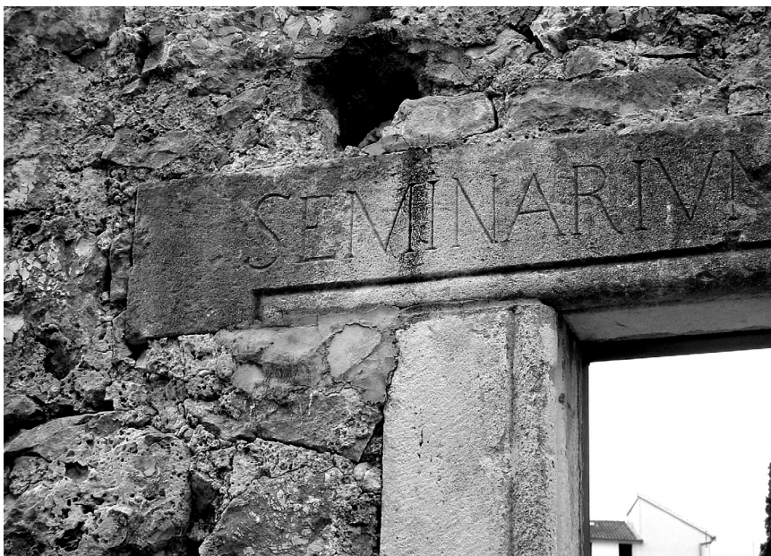
Glavni ulaz, detalj spoja dovratnika s nadvratnikom
