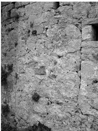
Južni zid perivoja s tragom spajanja starije i novije strukture
