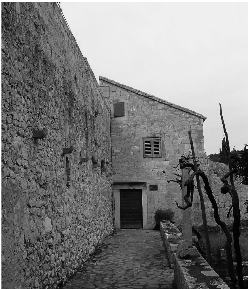
Šetnica uz južni zid Lucićeva sklopa, pogled prema zapadu
