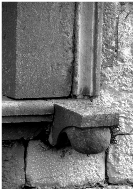
Konzola monofore na pročelju
