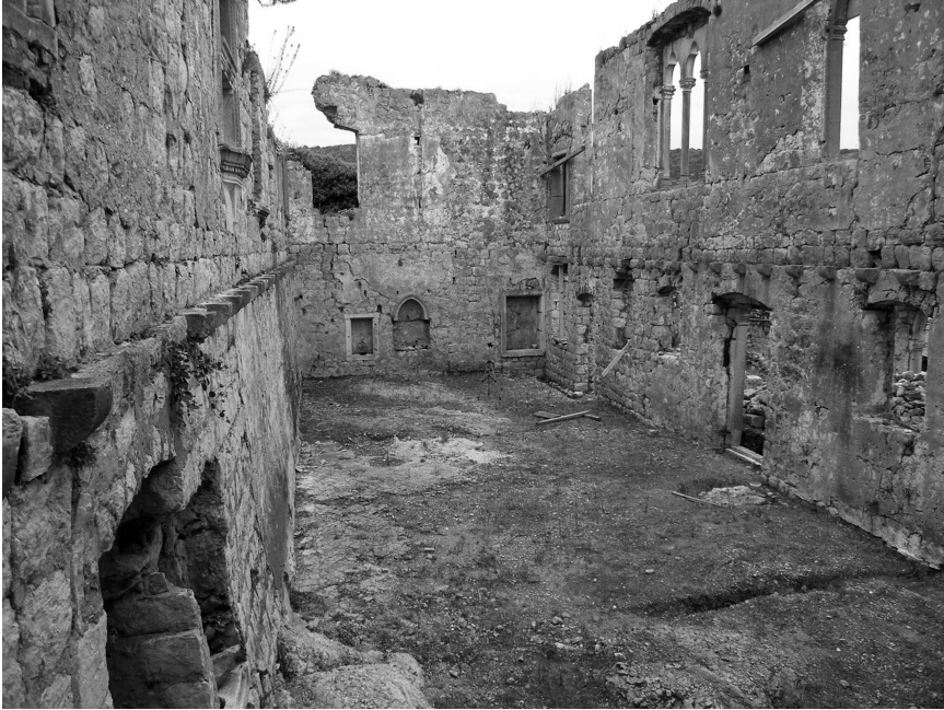
Unutrašnjost kuće, pogled na južni zid
