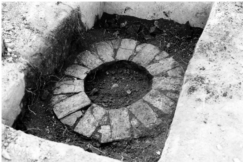
Filter za vodu s zidanim bunarom od opeke
