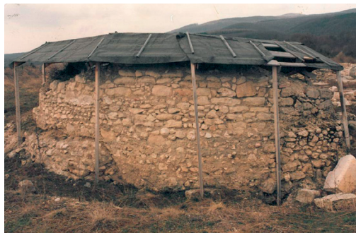
Slika 53. i 54. Konzervacija zidova drvom i terpapirom, snimila D. Sokač-Štimac
