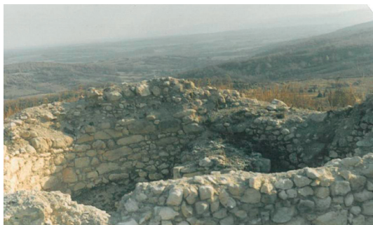
Slika 12. Unutrašnjost gotičke apside
