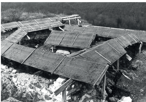
Slika 53. i 54. Konzervacija zidova drvom i terpapirom, snimila D. Sokač-Štimac
