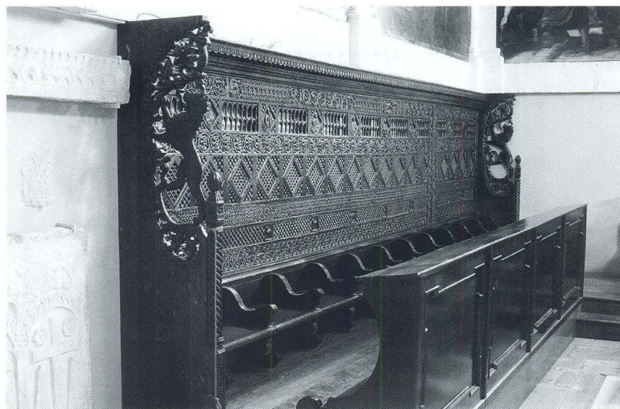
Restaurirane korske klupe
