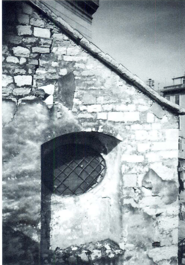
Sjeverni prozor na istočnom zidu kora
