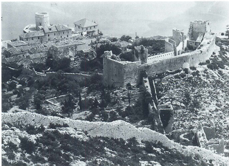
Mali Ston, pogled s jugozapada
