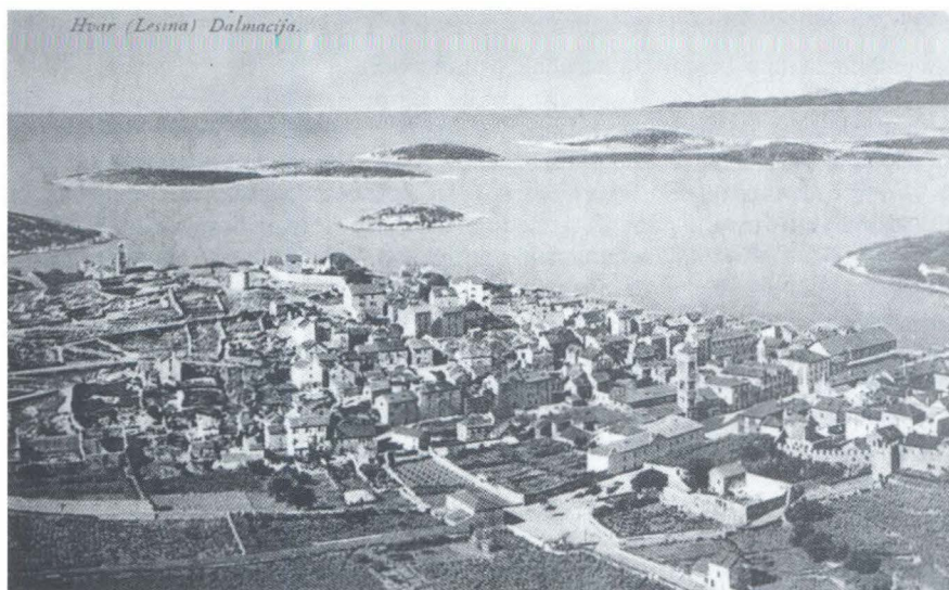
Predio Dolac u Hvaru početkom 20. stoljeća (Zbirka razglednica Konzervatorskog odjela u Splitu)
