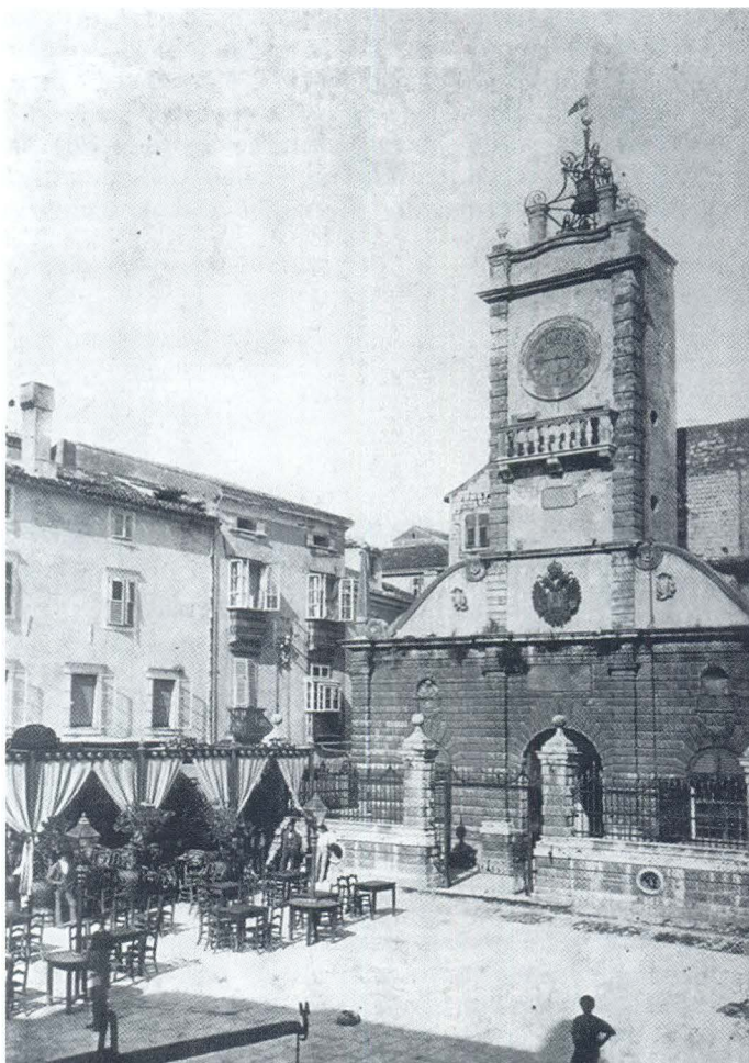
Vela straža oko godine 1854. U drugom je planu dio palače Califfi te pročelje zgrade u kojoj je na katu "Casino", a u prizemlju "Caffe" s terasom duboko u prostoru trga. (foto: T. Burato)
