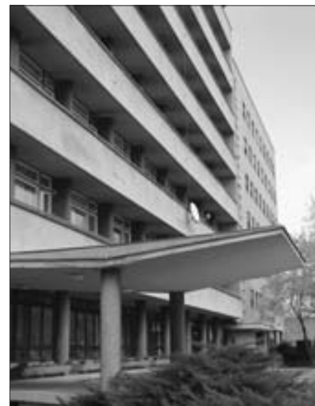
SL. 9. BOŽIDAR RAŠICA: POSLOVNA ZGRADA „JUGONAFETA”, KASNIJE „ELEKTROPRIVREDA” (PROJEKT IZVEDBE U FAZI IZGRADNJE PETOG KATA PREUZE O PEROSLAV ILJIĆ), 1954.-1956. (ULICA GRADA VUKOVARA 37)
