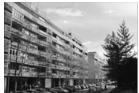
SL. 16. BOŽIDAR RAŠICA: DVIJE VIŠESTAMBENE ZGRADE, 1954.-1956. (VESELKA TENŽERE 1, 3, 5, 7, 9, 11, 13 I 15) FIG. 16 BOŽIDAR RAŠICA: TWO APARTMENT BLOCKS, 1954-1956 (VESELKA TENŽERE 1,3,5,7,9,11,13 AND 15)
