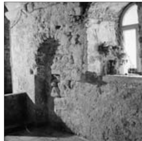
SL. 14. JUGOZAPADNA KAPELA CRKVE SV. LUKE NAKON SKIDANJA ŽBUKE
