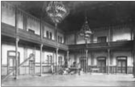
SL. 5. UNUTRAŠNOST GIMNASTIČKE DVORANE „HRVATSKOGA SOKOLA” FIG. 5 GYM „HRVATSKI SOKOL” – INTERIOR
