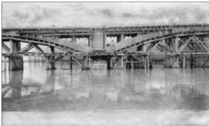
SL. 4. GRADNJA MOSTA NA VELIKOM STRUGU, IZGLED SREDIŠNJEG DIJELA MOSTA, 1916.
