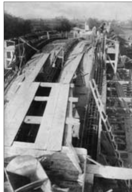
SL. 2. GRADNJA MOSTA NA VELIKOM STRUGU, PODIZANJE LUKOVA, 1916.
