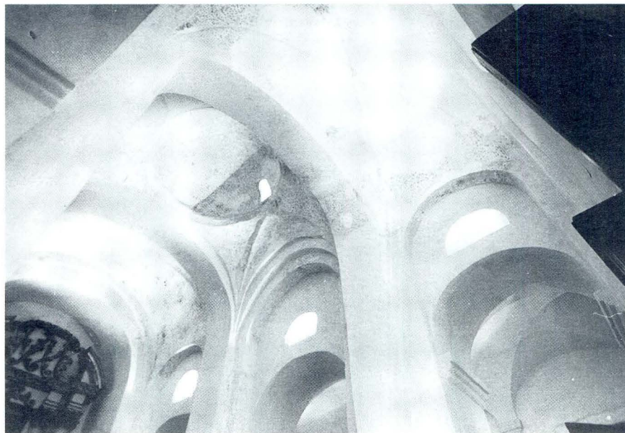
Svodovi crkve nakon sanacije
