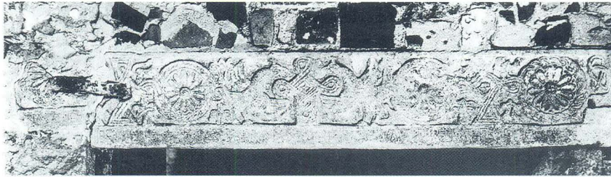
Izvorni položaj nadvratnika oslonjenog u peti gljivastog luka prije rekonstrukcije 30-tih godina
