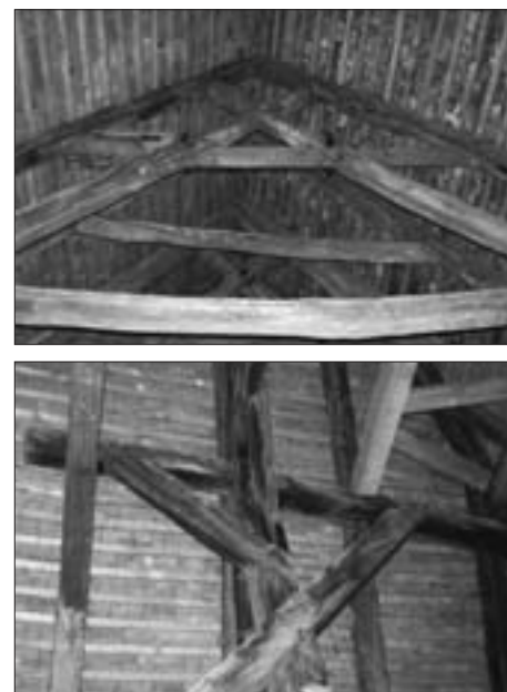
SL. 17. VELIKI TABOR: UNUTRAŠNOST KROVIŠTA PALASA FIG. 17 VELIKI TABOR: PALACE, ROOF SPACE
