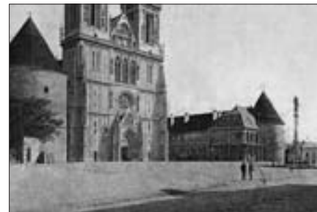
SL. 2. VIKTOR KOVAČIĆ: VANJSKI POGLED SA SJEVEROZAPADA NA ZAPADNE UTVRĐENE ZIDINE BEZ BAKAČEVE KULE, KAPTOLSKI TRG, POSLIJE 1906. FIG. 2 VIKTOR KOVAČIĆ: VIEW OF THE WESTERN FORTIFICATIONS WITHOUT THE BAKAČ TOWER FROM NORTHWEST, KAPTOL SQUARE, AFTER 1906
