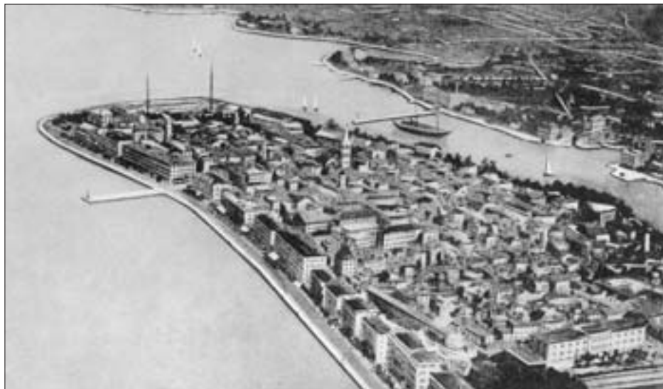
SL. 3. ŽADAR 1931. GOD. U PRVOME PLANU NEPRIMJERENA IZGRADNJA NA JUGOZAPADNOJ OBALI. FIG. 3 ŽADAR IN 1931. INAPPROPRIATE CONSTRUCTION ON THE SOUTH-WESTERN COAST (FOREGROUND)
