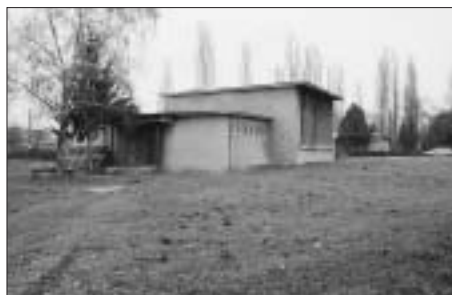
SL. 20. ZGRADA DVORANE ZA SEKCIJE PATOLOŠKE ANATOMIJE FIG. 20 PATHOLOGY BUILDING
