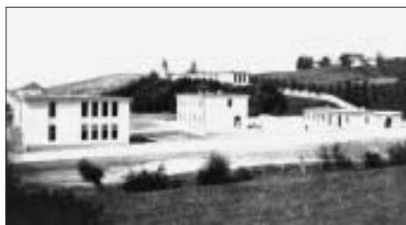
SL. 5. ZGRADE S POKROVOM OD KROVNE LJEPENKE: SKLOP GARNIZONSKE BOLNICE, KUNIŠĆAK 40 (DANAS MORH)
