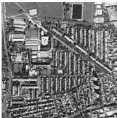
SL. 26. NASELJE „PRVE HRVATSKE ŠTEDIONICE” NA TREŠNJEVKI FIG. 26 HOUSING DEVELOPMENT „PRVA HRVATSKA ŠTEDIONICA” („FIRST CROATIAN SAVINGS BANK”) IN TREŠNJEVKA
