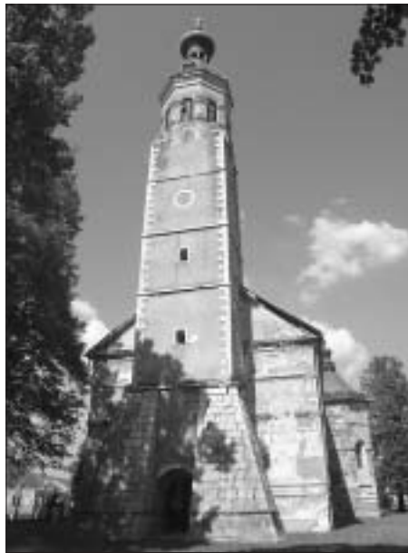
SL. 5. SABORNA CRKVA U PLAŠKOME, PROČELJE DANAS. JASNO SE UOČAVAJU KUPOLE TORNJA I KAPELE, DODANE OD HOLJCA PRI HISTORICISTIČKOJ OBNOVI CRKVE.
