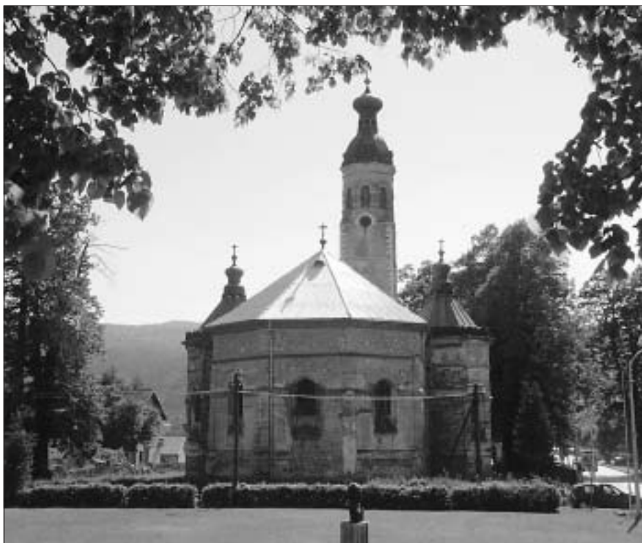
SL. 11. SABORNA CRKVA U PLAŠKOM, POGLED NA SVETIŠTE, DANAŠNJE STANJE NAKON OŠTEĆENJA APSIDE U DRUGOM SVJETSKOM RATU, OBNOVLJENE S REDUCIRANOM ARHITEKTONSKOM RAŠČLAMBOM
