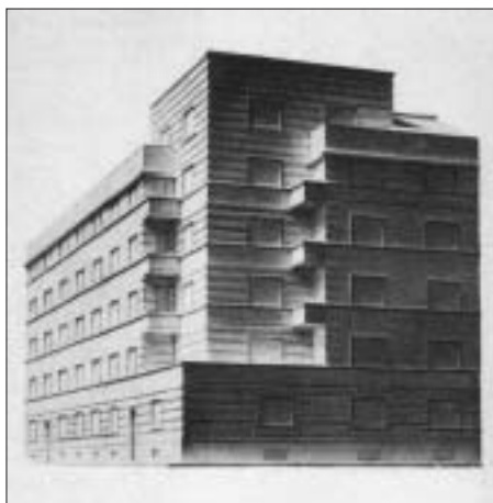
SL. 2. STAMBENA UGLOVNICA GLAVNE BRATIMSKJE BLAGAJNE ZA OSIGURANJE RUDARSKIH RADNIKA, KNEZA MISLAVA 18 – KNEZA DOMAGOJA – KRIZANICEVA, 1928.-1929., STJEPAN GOMBOŠ, IZVELO GP ING. LAV KALDA
