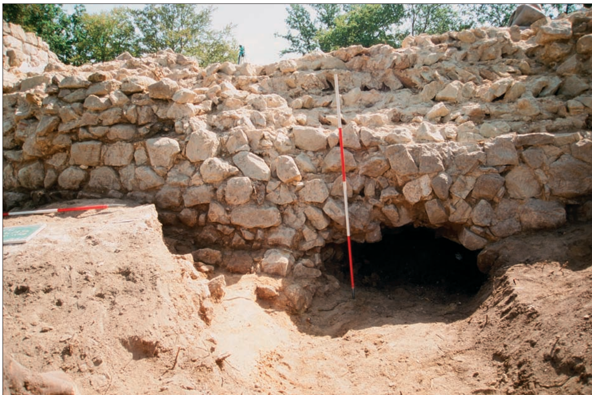
Sl. 4 Pogled na zapadno lice zida SJ 61 i temeljnu stopu SJ 197 te na lučno udubljenje ispod zida na mjestu uleknuća SJ 184 (snimila: T. Tkalčec).
