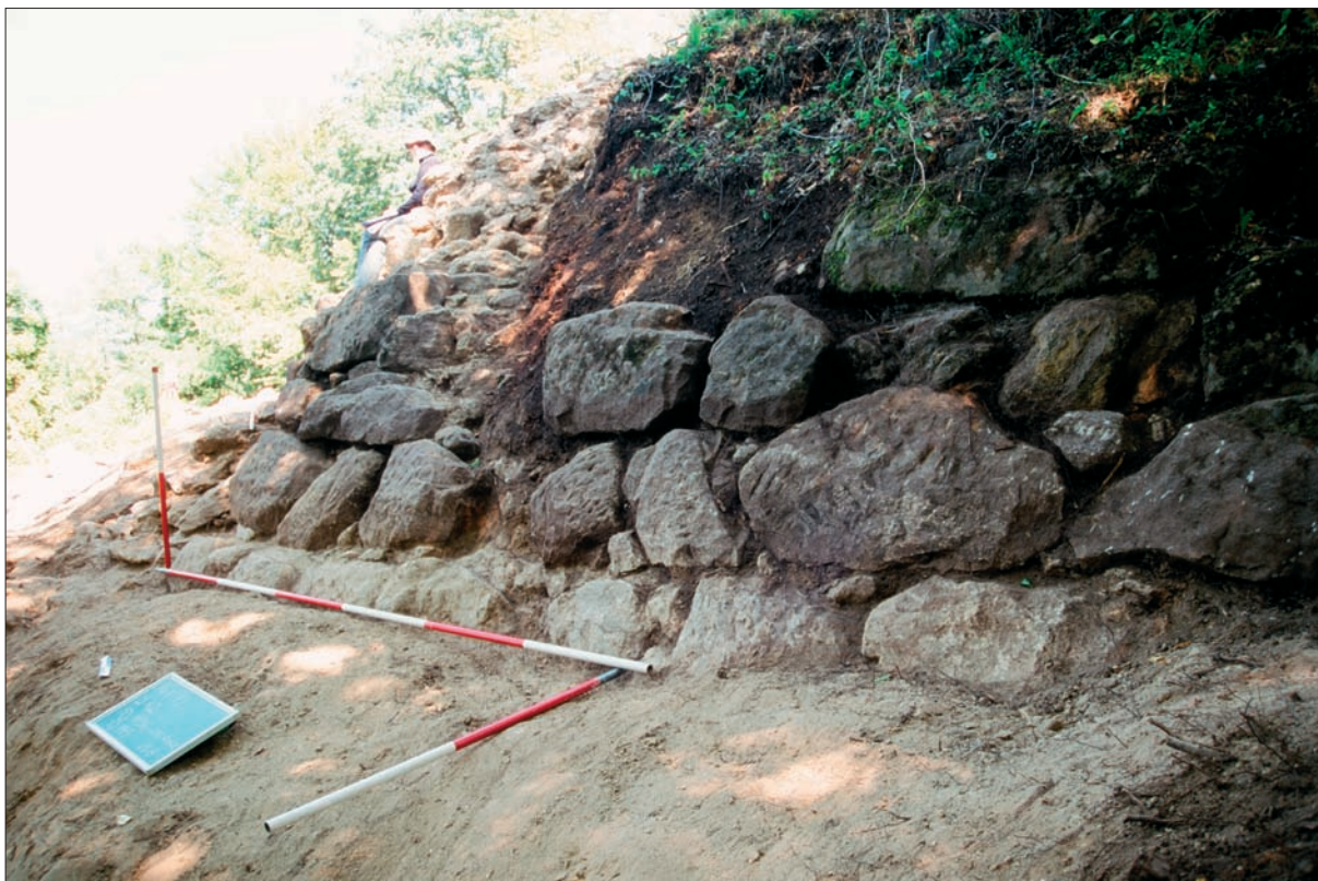
Sl. 9 Veliki blokovi lica zida branič-kule SJ 196, pogled s jugozapada (snimila: T. Tkalčec).
