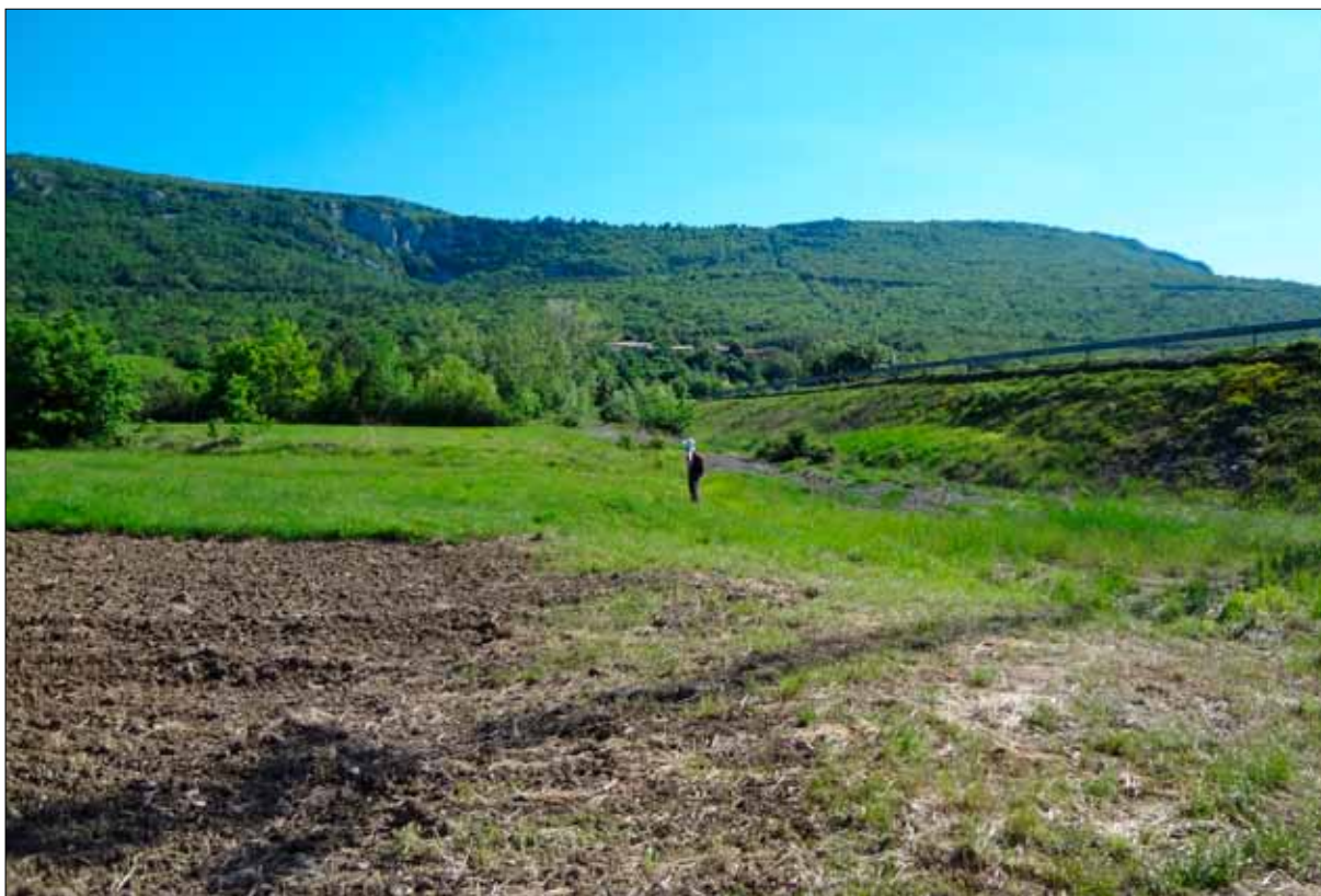
Sl. 7 Početak trase nove spojne ceste Lupoglav – Vranja, kod nalazišta AN 1 – Rušanski potok (snimila: A. Tonc).
