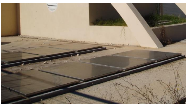
Slika 5. Vanjski podzemni bazen s crpkama
