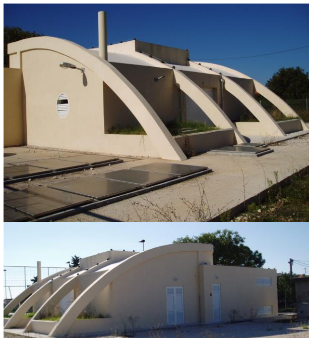
Slika 2. Crpna stanica Arbanasi - Zadar
