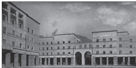
SL. 17. P. ROSSI DE PAOLI: ZGRADA I.N.A. NA PIAZZA DELLA VITTORIA U BOLZANU, 1938. GODINA
