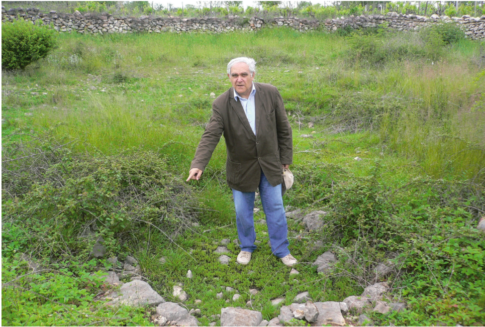
Slika 5. Autor članka pokazuje ostatke zida jednog od tri nekadašnja obzidana bunara - Pilipovca.
