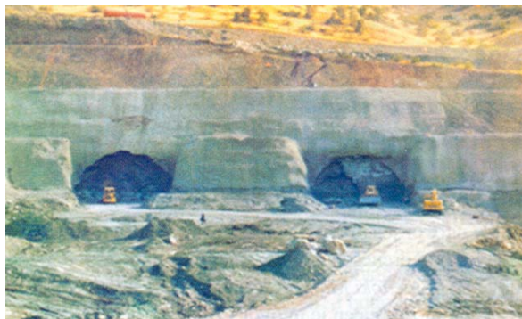
Slika 4. Iskop derivacijskih tunela na HE Bekhme u Iraku
