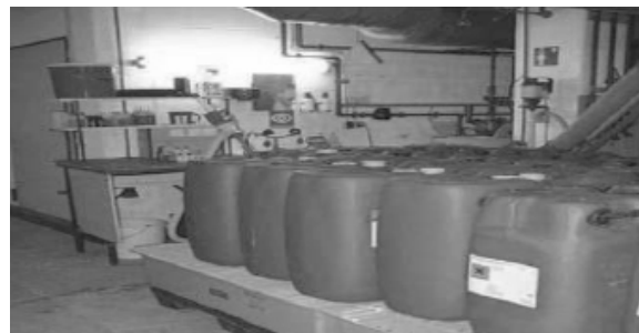
Slika 1. Pravilno postavljene posude sa zapaljivim tekućinama
