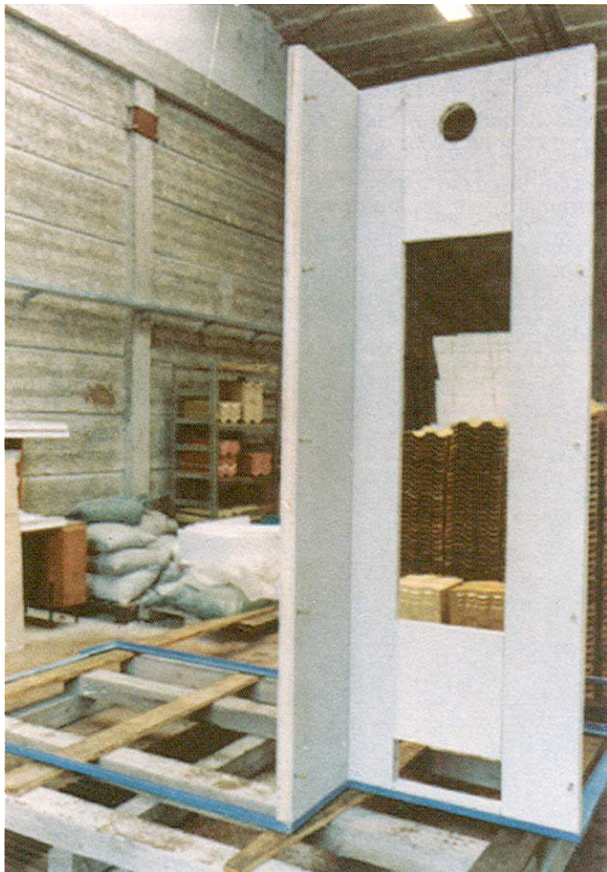
Slika 4. Sastavljanje sanitarne jedinice
