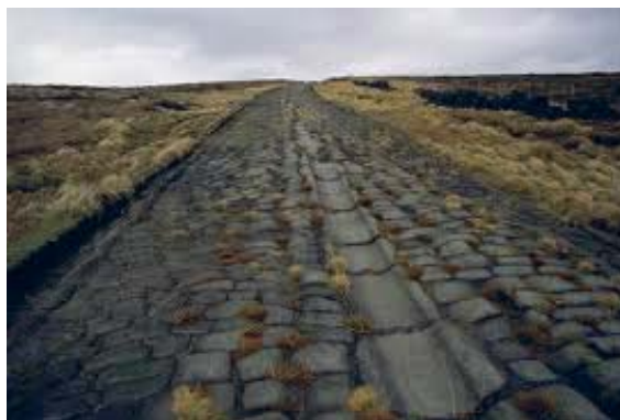
Slika 1. Primjer očuvane rimske ceste u usponu s centralnom odvodnjom oborinske vode
