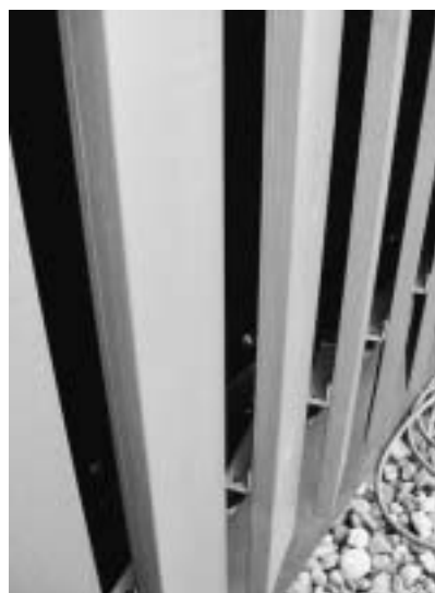
Slika 12. Način učvršćenja letvičastog pročelja
