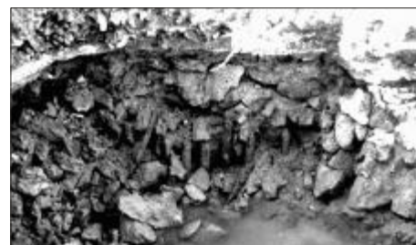
SI. 19. Fotografija ostataka drvenih pilota na kojima su temeljeni lazareti
