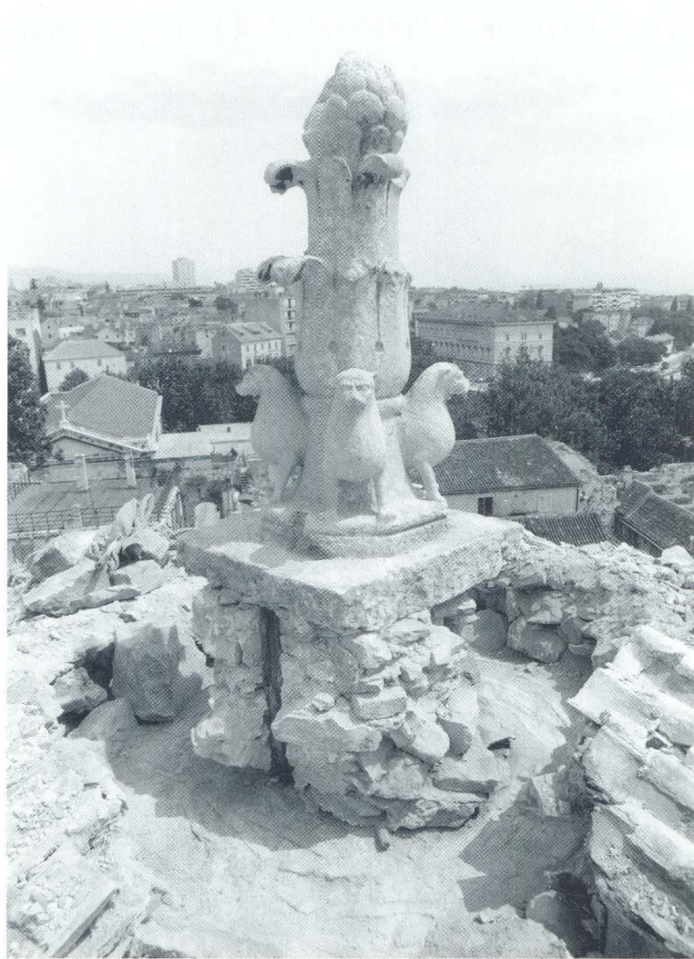
Romanički akroterij na vrhu krova tijekom radova 1996. godine. Strelicom je označena bakrena šipka - nosač lanca za svijećnjak u unutrašnjosti
