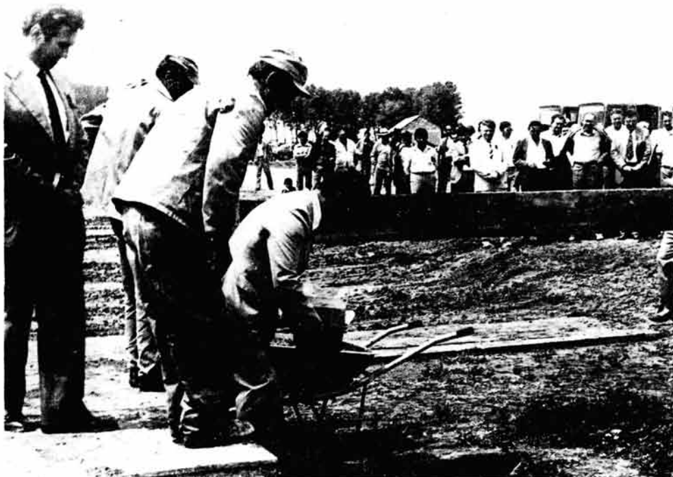
Polaganje kamena temeljca za staju u P. Podgajcima
