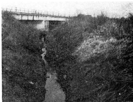
Slika 2. Industrijski kolektor na ulazu u glavni gradski kolektor
