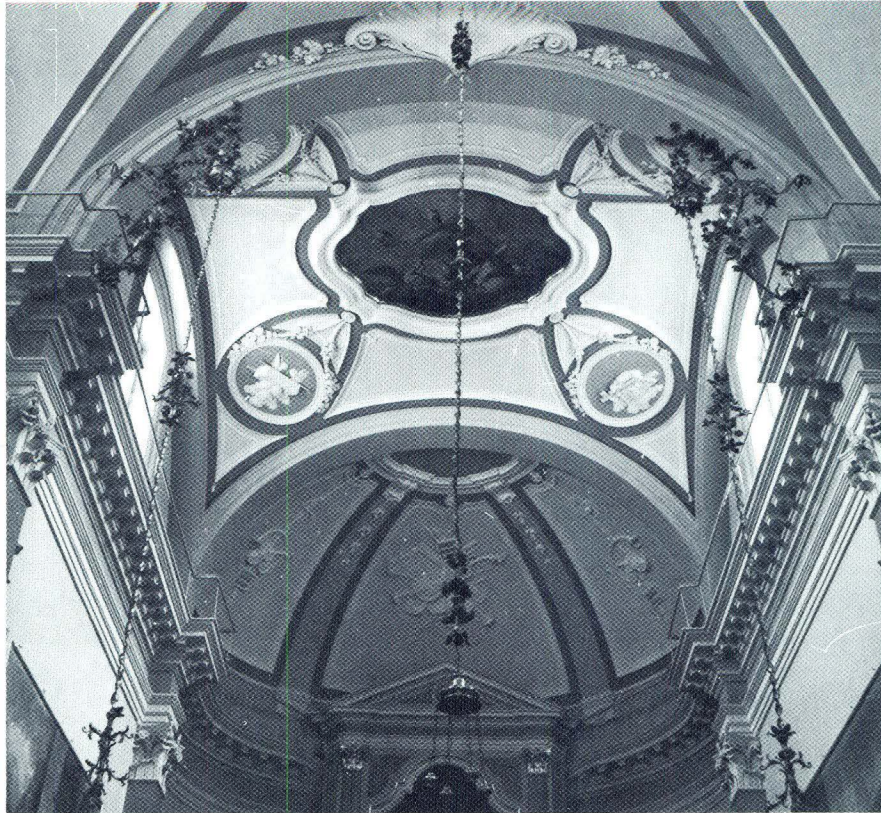
Crkva sv. Antuna Opata, Veli Lošinj svodovi svetišta
