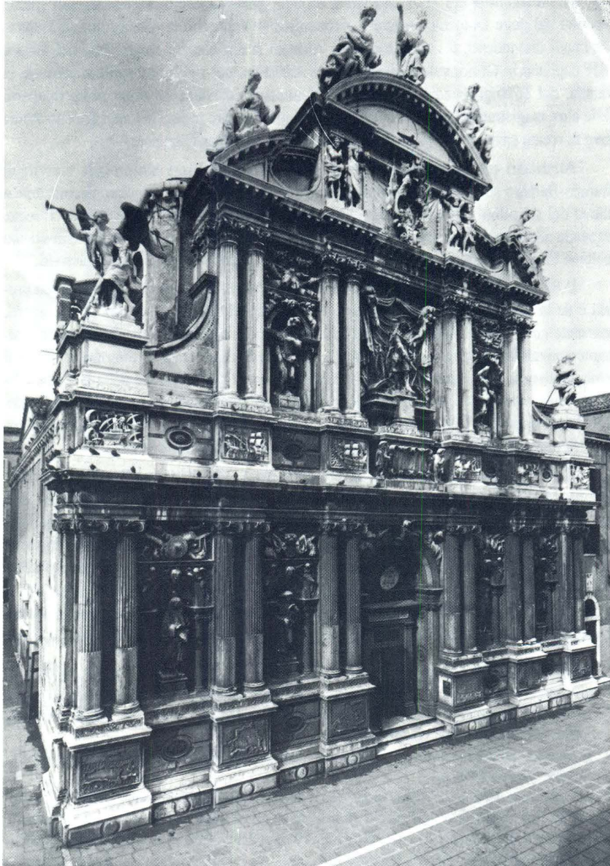
Giuseppe Sardi, Facciata della chiesa di Santa Maria del Giglio, 1678-1680. Venezia
