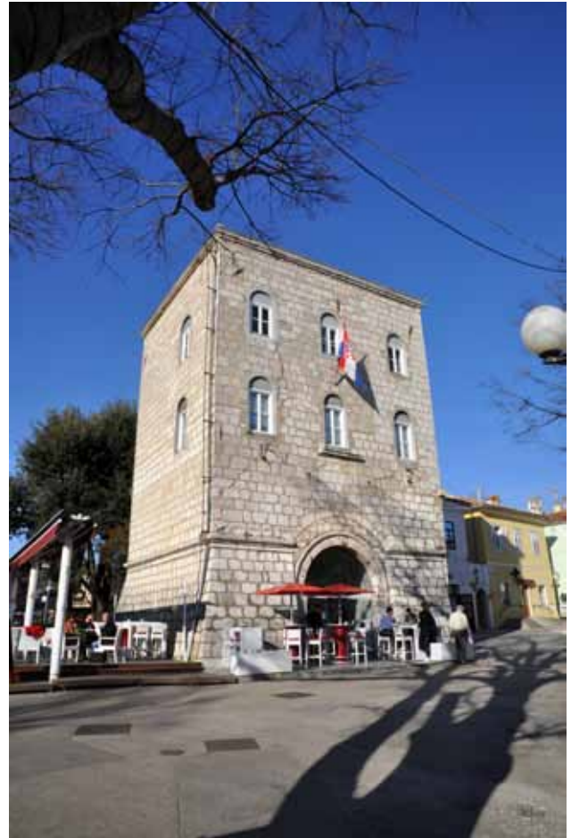
4 Krk – gradska vijećnica (kula gradske straže), južno pročelje Krk – City hall (city watch tower), south side
