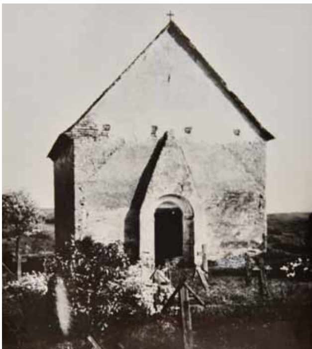
16 Crkva sv. Martina, Lovčić, 13. st. – zapadno pročelje prije obnove, stanje 1968. (foto: B. Kralik, fototeka MK AKOSB)
